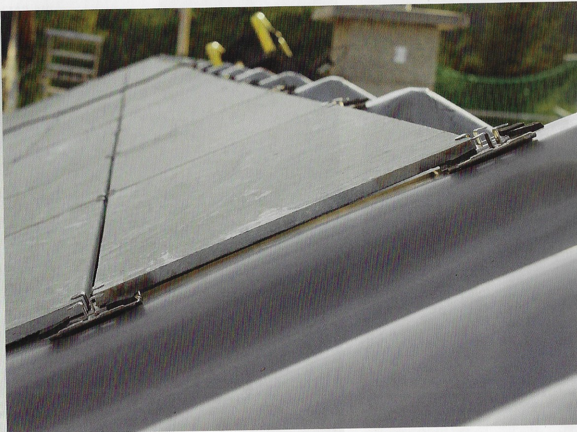
Sicht auf die seitliche Befestigung der Schieferplatten: Die Klammern werden in einem festgelegten Raster auf den Konterlatten befestigt und die Schiefer werden mit offener Kreuzfuge (1 cm) verlegt.
