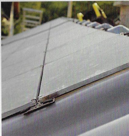
Schieferplatten über wasserdichtem Unterdach.
